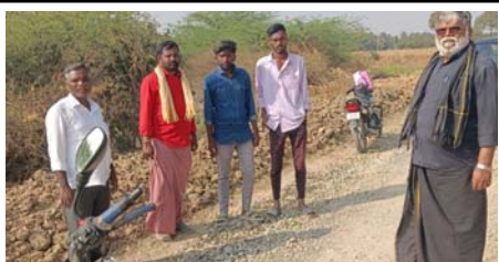
వీరాపురం రోడ్డు పనులను పరిశీలించిన పంచాయతీరాజ్ శాఖ డి.ఈ. వెంకటేశ్వర్లు
