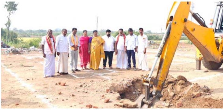
పంపనూరు సుబ్రహ్మణ్యేశ్వర స్వామి ఆలయ ప్రాంగణంలో మరుగుదొడ్ల నిర్మాణాన్ని పరిశీలిస్తున్న స్వచ్ఛభారత్ డైరెక్టర్ భవాని రవికుమార్
