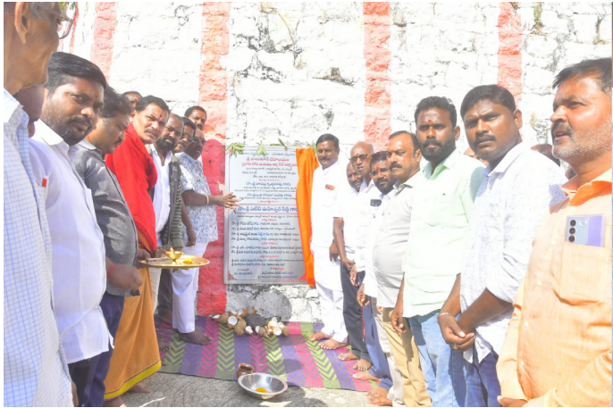
హనుమాన్ ఆలయ నిర్మాణానికి శంకుస్థాపన చేసిన ఎమ్మెల్యే మహేశ్వర్ రెడ్డి
